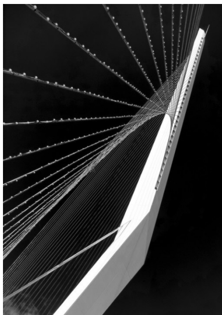
Tragwerk Pylone und Abspannung einer Brücke in Jerusalem
